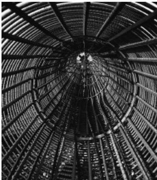
Armierungskorb eines Energiepfahls mit Wärmetauscherrohren. / Cage d'armature d'un pieu avec des tubes échangeurs.
