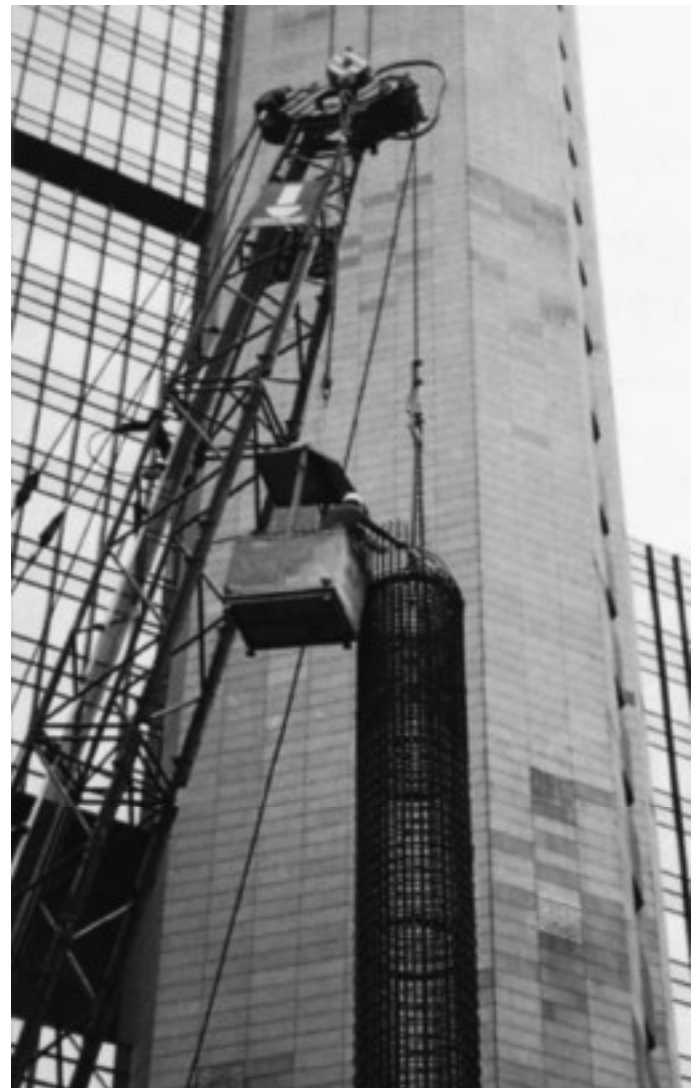
Einbau eines Armierungskorbs in das Bohrloch
