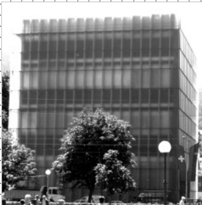
enercret – Energiesystem zur Klimatisierung am Beispiel Kunsthaus Bregenz, Austria
