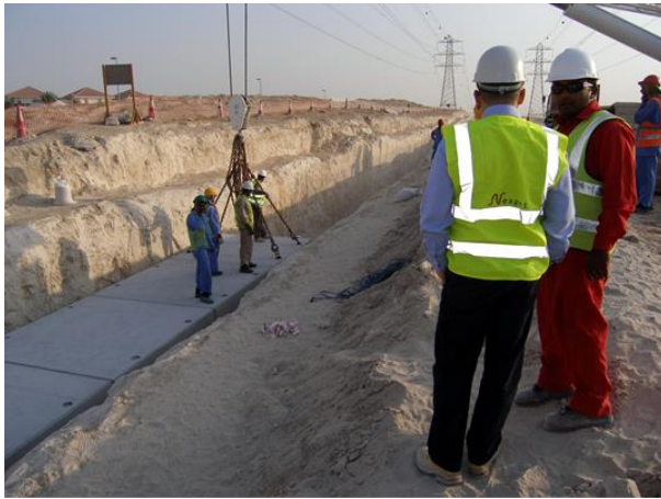
Costruzione del condotto di cablaggio con il metodo di costruzione in superficie
