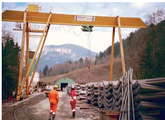
Cunicolo Sörenberg in fase di costruzione
