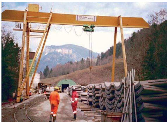
Galerie de Sörenberg en phase de construction
