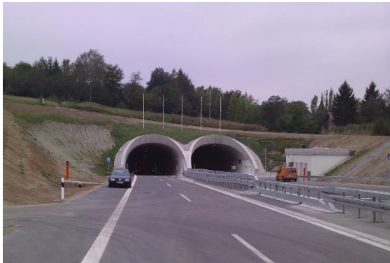
Imbocco est del tunnel di Leutenbach
