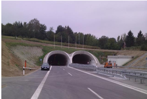
Portail Est du tunnel Leutenbach
