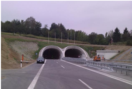
Ostportal des Tunnels Leutenbach
