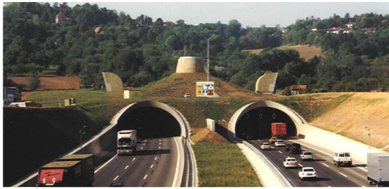
Imbocco nord del tunnel di base di Engelberg
