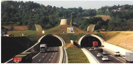
Portail nord du tunnel de Engelbergbasis
