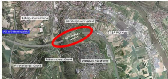
Emplacement du tunnel du Katzenberg près de Würzburg sur la BAB A3 (auteur: V-KON.media GmbH)
