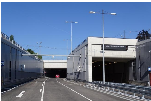
Il portale sud del Luise-Kiesselbach-Tunnel
