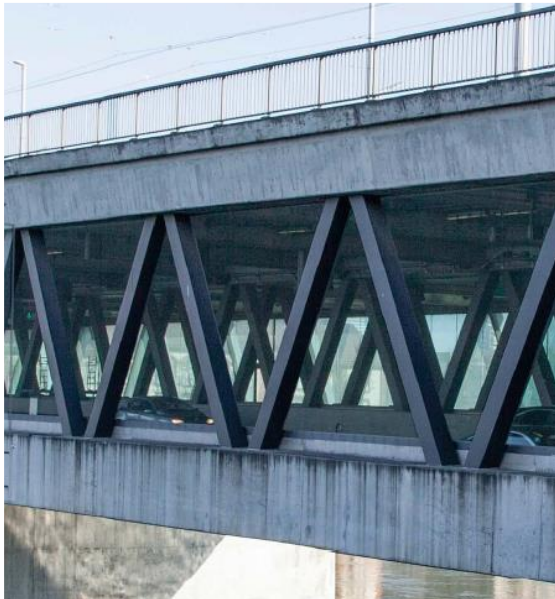
Struttura di sostegno del ponte Dreirosenbrücke
