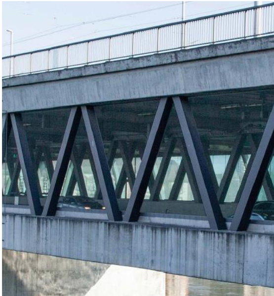
Structure porteuse du pont Dreirosenbrücke
