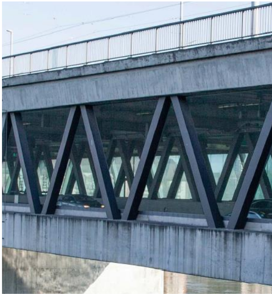
Tragwerkstruktur der Dreirosenbrücke
