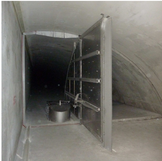
Installation d'un clapet d'isolation
