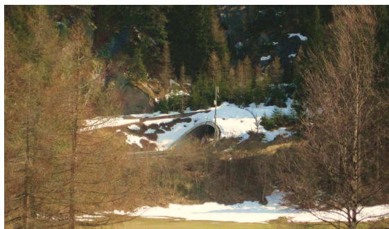
Tunnel de Bärenburg dans les Alpes
