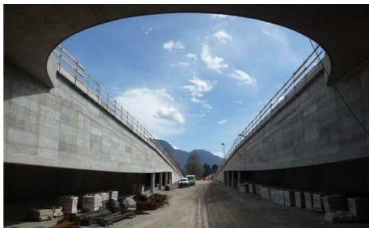
Bretelle de sortie à la gare de Meran
