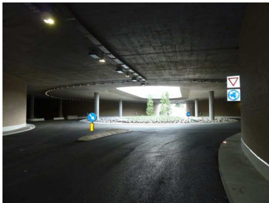
Rond-point couvert vers la gare
