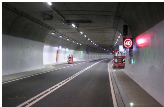
Piazzola di emergenza galleria Gmünder Einhorn
