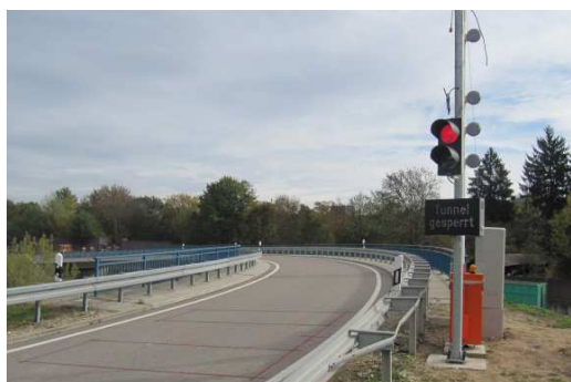
Barrières à l'entrée ouest
