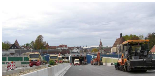
Portail Est du tunnel de Gmünder Einhorn
