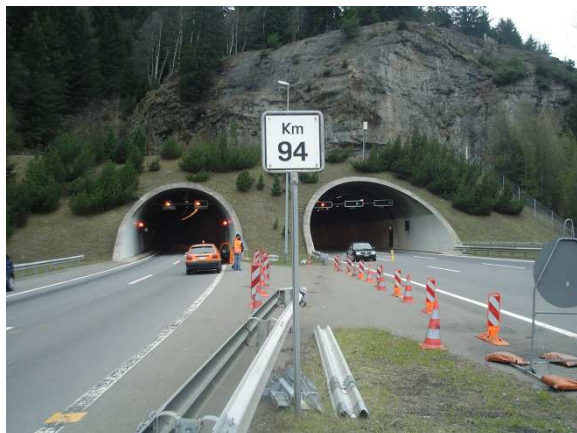
Portale sud della galleria Pardorea
