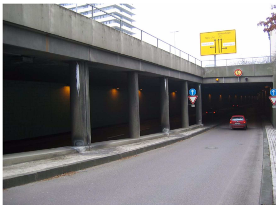
Tratto di imbocco nella galleria Bismarckring a Ulm
