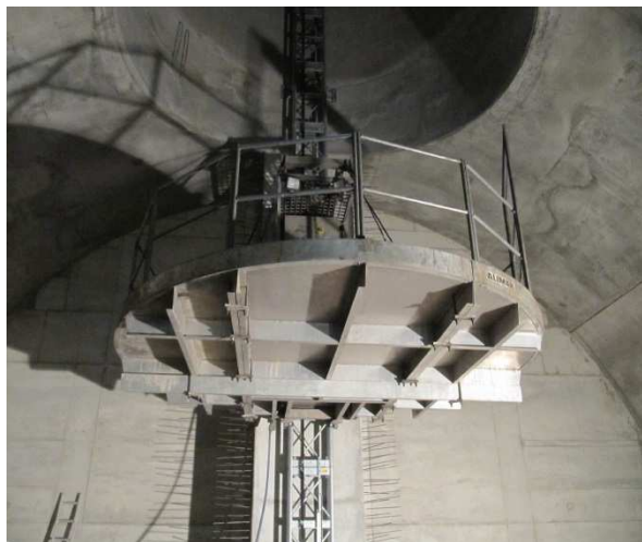
Lavori di montaggio sull'impianto saliscendi del camino di espulsione aria alto 160 m
