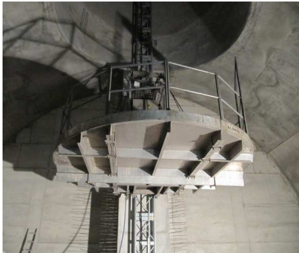
Montagearbeiten an der Befahrungsanlage des 160 m hohen Abluftkamins
