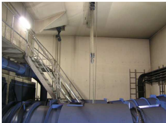
Situazione di montaggio per la sostituzione dei ventilatori assiali di aspirazione dei gas
