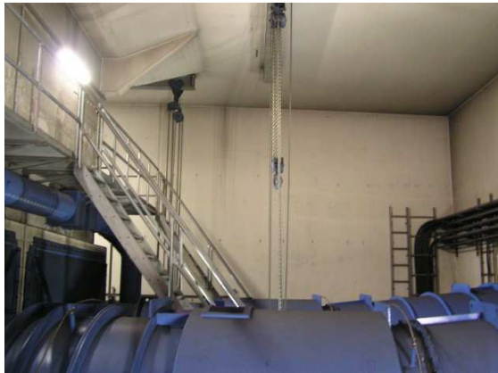
Montagesituation zum Austausch der Axialventilatoren für Rauchabsaugung
