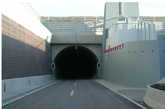
Portail Ouest du tunnel sous la Weser
