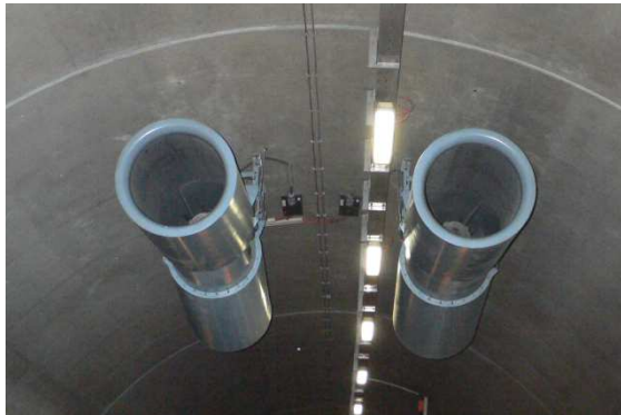
Ventilateurs de jet « Banana jet »
