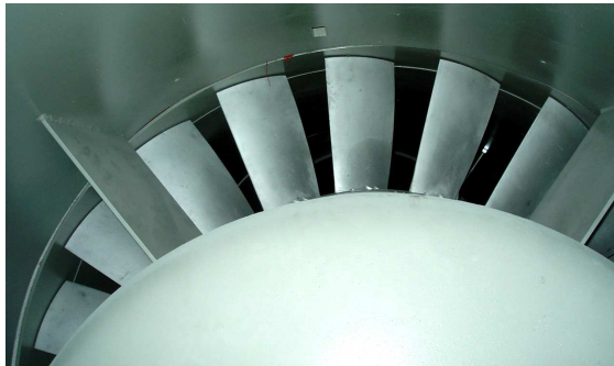
Ventilateur d'extraction d'air vicié
