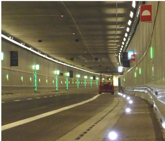
Tubes ouest du tunnel
