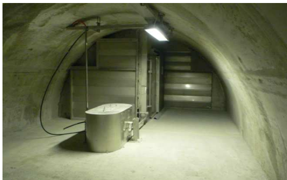
Serrande in cunicolo trasversale tra canna nord e sud della KWT
