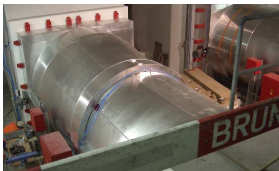
Montaggio dei nuovi ventilatori per l'estrazione dei fumi
