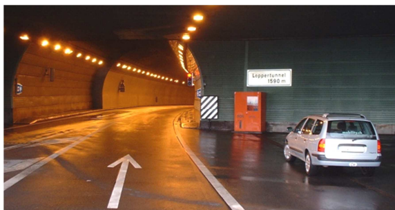
Portale Nord della galleria Lopper
