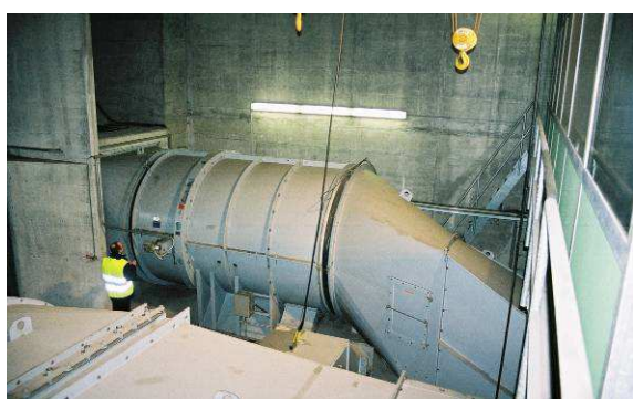
Ventilateur aspirant avant assainissement
