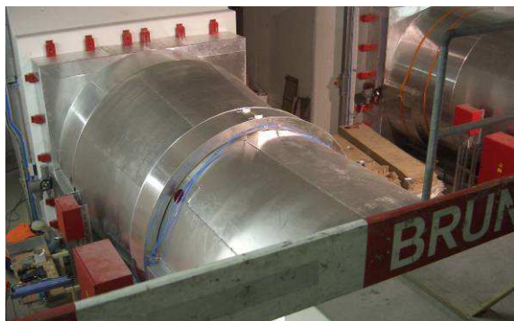
Montage des nouveaux ventilateurs aspirants
