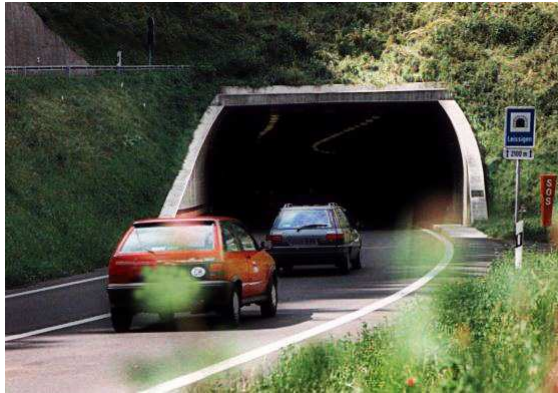
Tunnel de Leissigen
