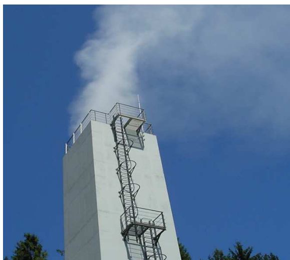
Fuoriuscita dei fumi durante una prova con fumo
