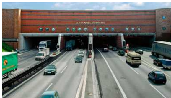
Portale nord della galleria sotto l'Elba con quattro canne
