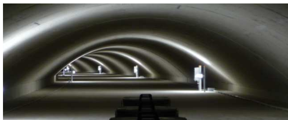
Canale di espulsione dell'aria, 1. galleria, in cls gettato in opera, dopo la ristrutturazione
