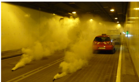
Essai de fumées froides pendant la mise en service
