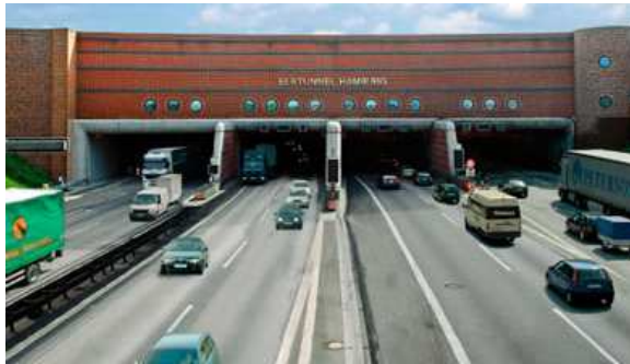
Portail nord du Elbtunnel, composé de 4 tubes
