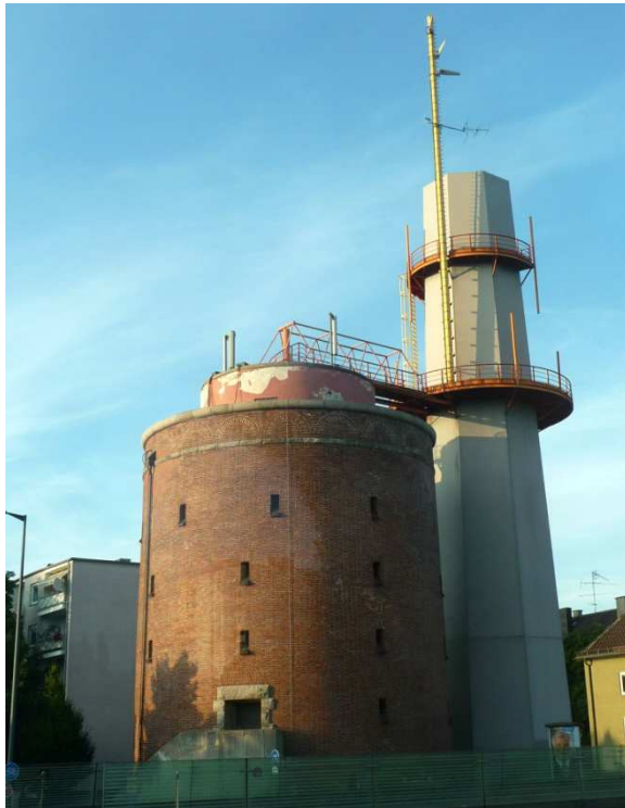
Camino di scarico dell'aria al portale ovest
