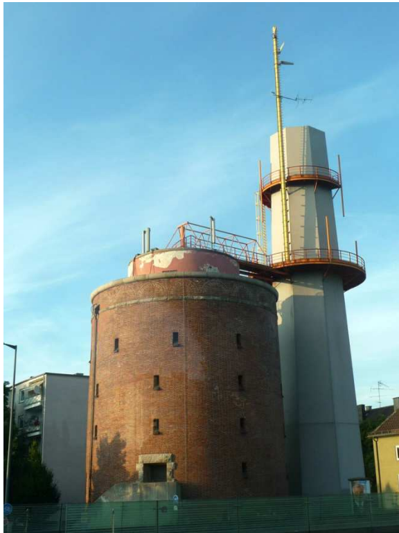
Cheminée d'évacuation de l'air vicié au portail ouest
