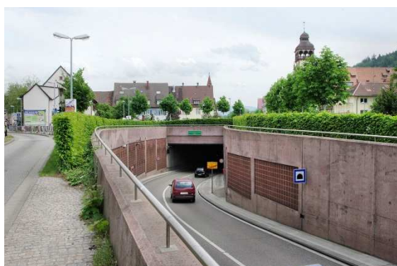
Galleria artificiale adiacente
