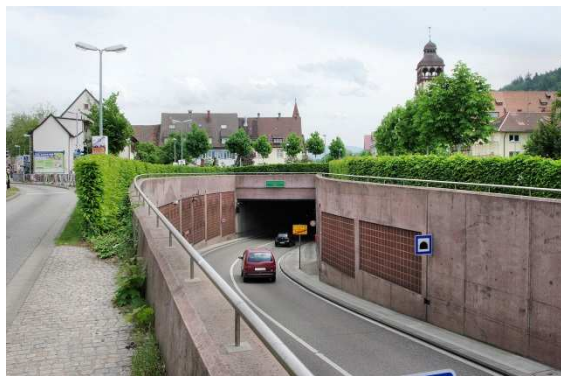
Accès au tunnel de la Schützenallee
