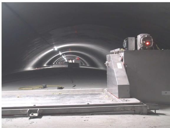
Gaine de ventilation et clapet de désenfumage avec moteurs
