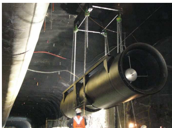
Montaggio di un ventilatore ad impulso
