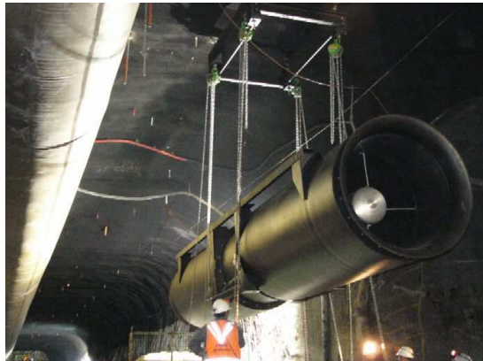
Montage d'un ventilateur de jet
