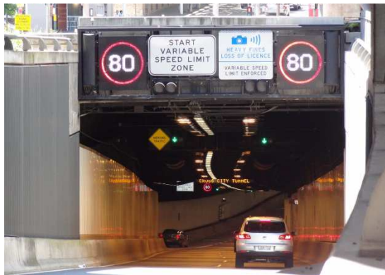
Entrée du tunnel à Darling Harbour
