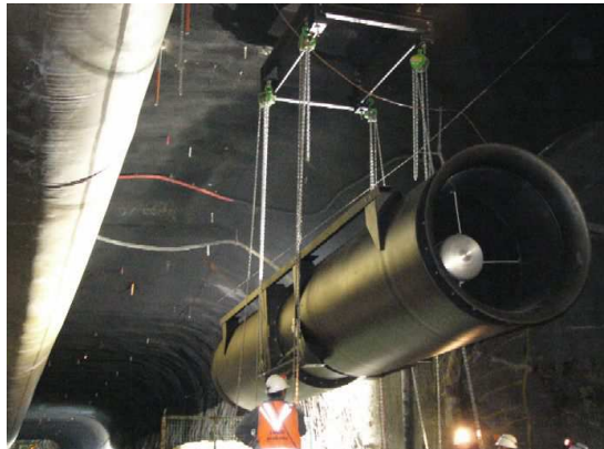
Jet fan installation
