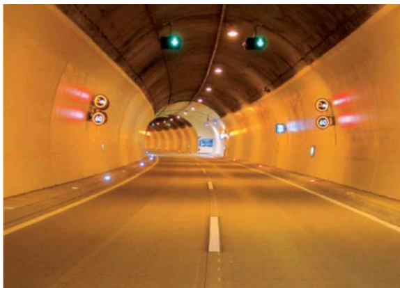
Tunnel d'Amberg après la rénovation
