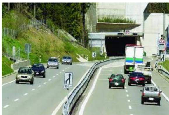
Portale della galleria Vue-des-Alpes
