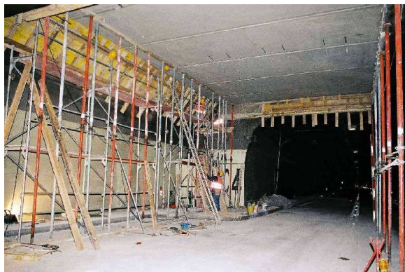
Costruzione delle nicchie per i ventilatori a getto
