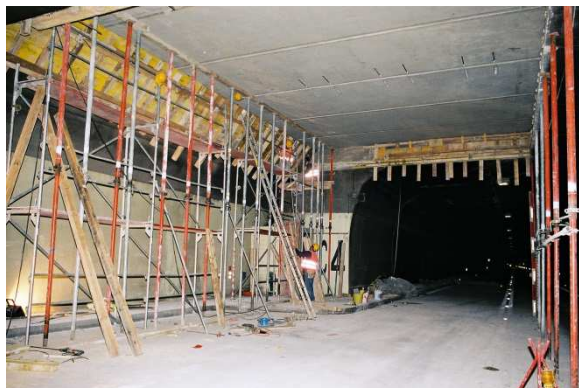
Construction de niches pour les ventilateurs de jet
