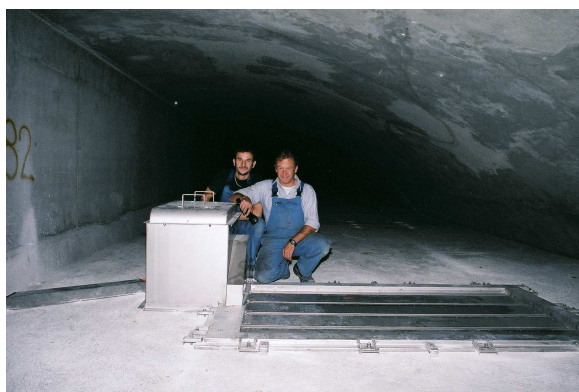
Montage du dernier clapet
