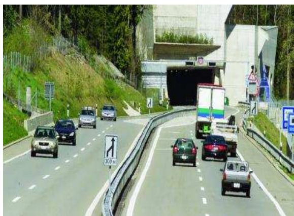
Portail du Tunnel de la Vue-des-Alpes
