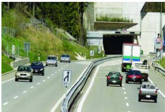
Tunnel portal Vue-des-Alpes
