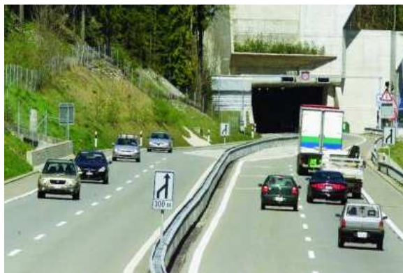
Portal des Tunnels de la Vue-des-Alpes
