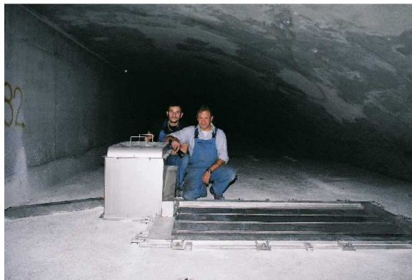
Einbau der letzten Klappe
