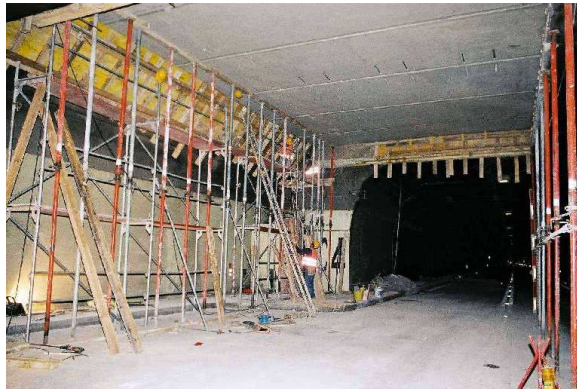
Bau der Nischen für die Strahlventilatoren
