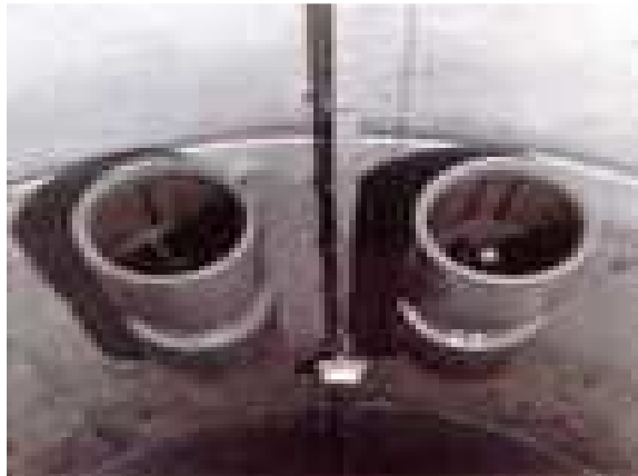
Ventilatori a getto con regolazione del numero di giri
